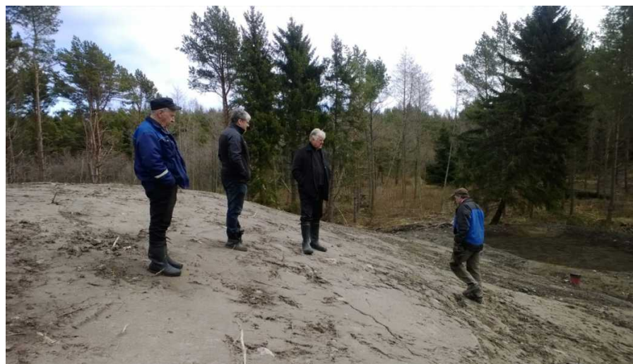
Trygve Packalén gjorde en inspektion 27.4 på deponin tillsammans med arbetsgruppen. Återstår att så gräs, anlägga vassbädd och provtagningsbrunnar. Därefter kan slutgranskning göras.
